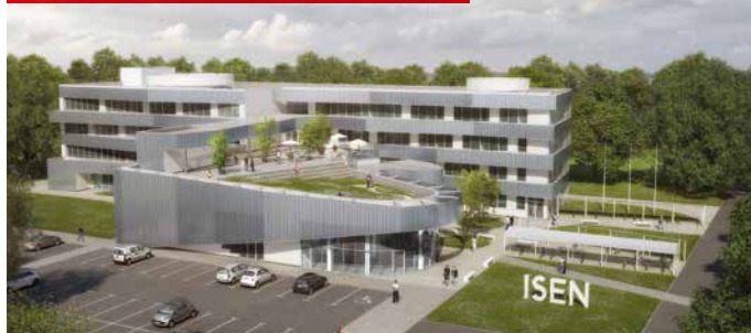
Construction d'un bâtiment à Nantes (début des travaux en mai 2020)
